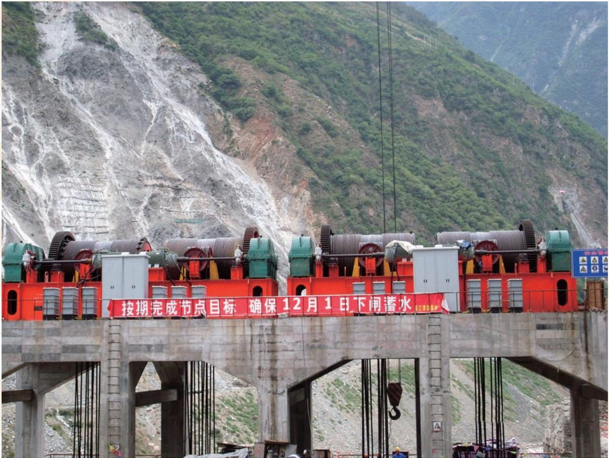
为大渡河瀑布沟水电站设计、生产的2×4000kn固定卷扬机
